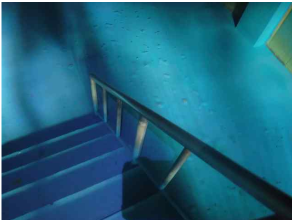
〔배수지 1호지 : 안전난간 상태양호〕
