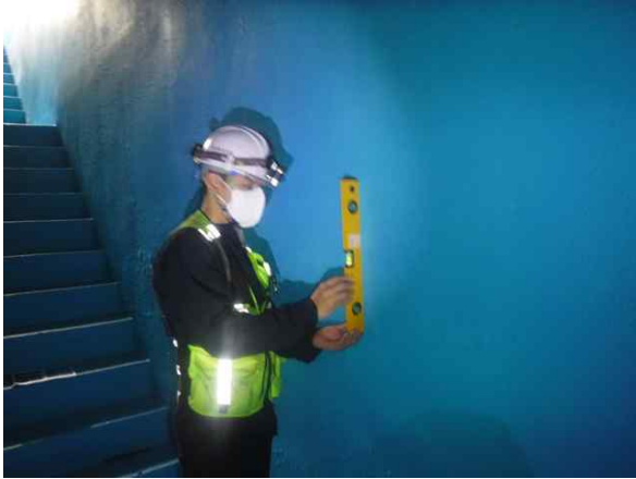
〔배수지 내부 : 기울기측정 전경〕
