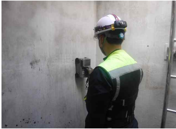
(콘크리트 피복두께 측정)
