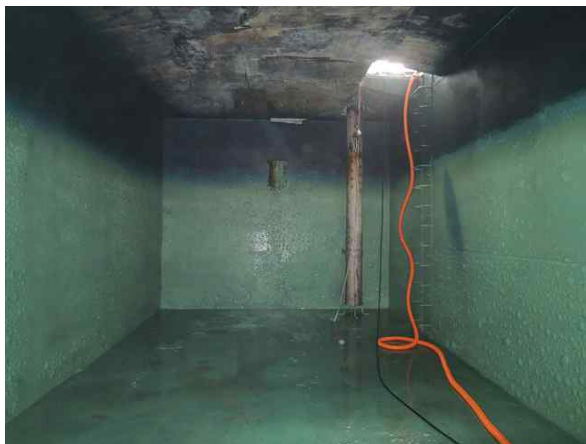
[배수지 내부 전경]
