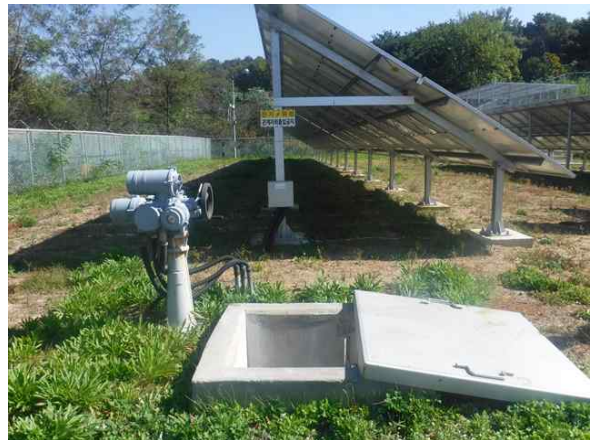
〔1호지 유입밸브실 : 점검구덮개 상태양호〕
